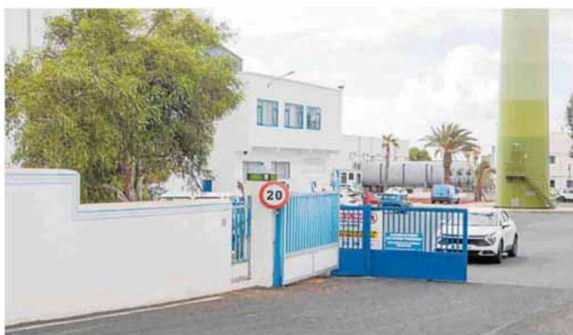
Instalaciones centrales de Canal Gestión Lanzarote en las proximidades de Las Caletas. COBER LANZAROTE.
