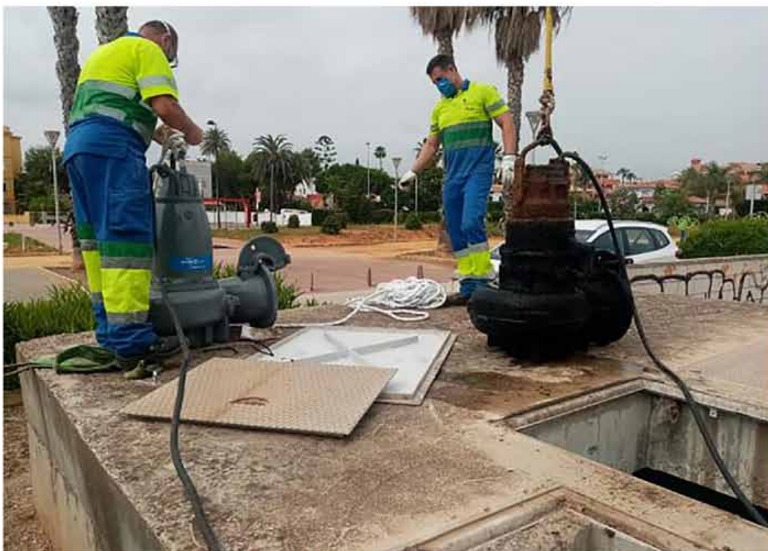
Limpieza de las estaciones pluviales de Dénia. Aqualia.
