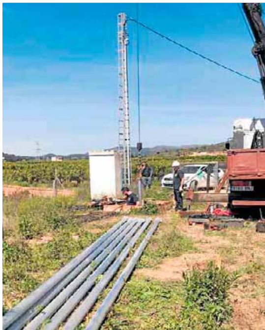
Reparación de bomba y tubería de extracción de agua en un pozo. LL
