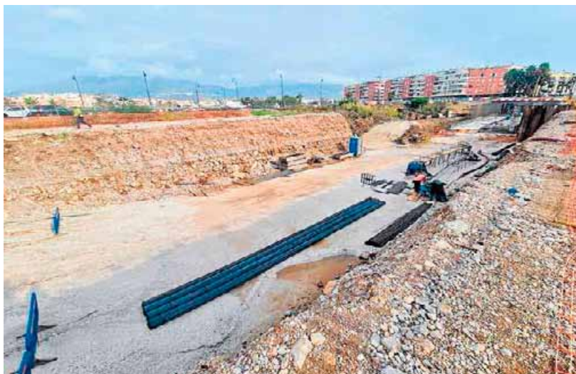
Vista general de las dimensiones que tendrá el tanque de tormentas. L. CÁDIZ
