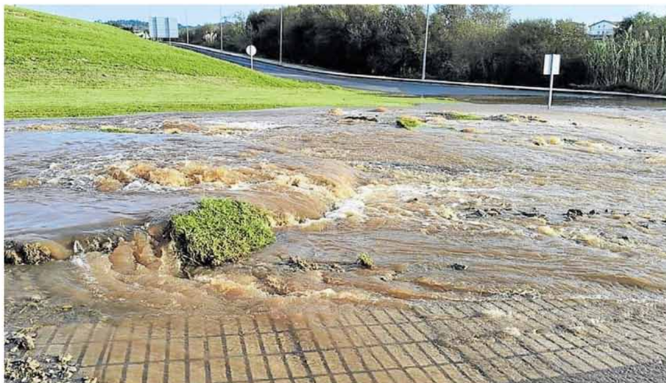
El reventón de la tubería se detectó en el acceso al campo de fútbol de Arteaga, en Erandio. LUIS CALABOR
