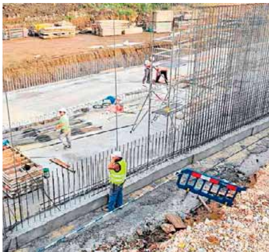
Avance de los trabajos. L. CÁDIZ
