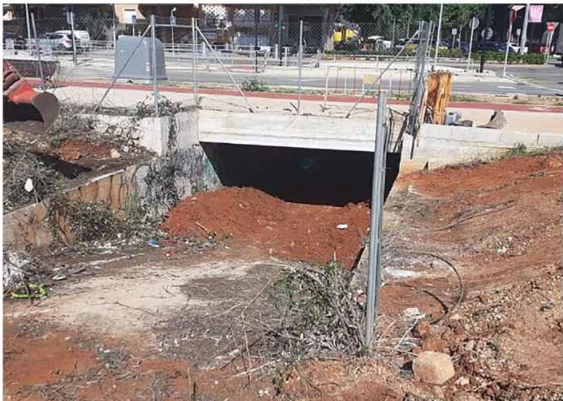
Limpieza en el colector de Joan Fuster
